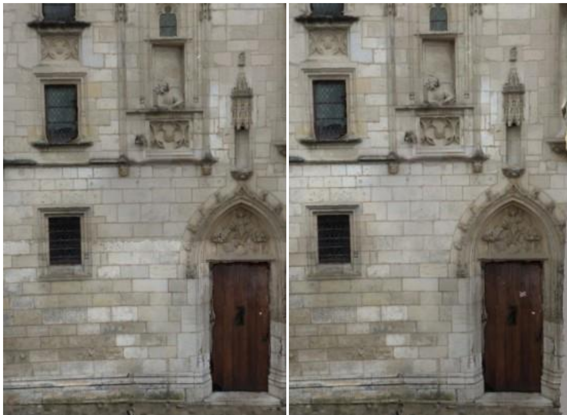
建筑外墙重建 - 不含（左侧）/含（右侧）瓦片间色彩均衡：大大降低了瓦片间的色差。
